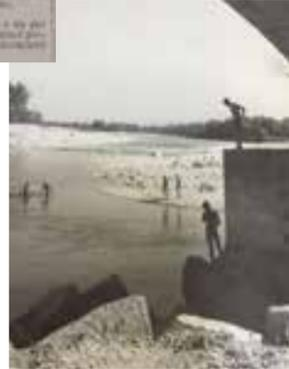
Ponte FFSS., anno 2002, erosione alle pile fino a 13 mt., tanto che alcuni ragazzi coraggiosi, per diverse estati, si tuffavano.
