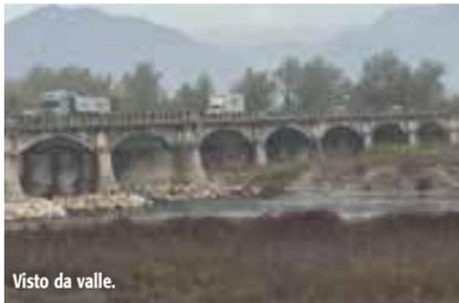
Foto del 26.10.16. Situazione critica in caso di piena a partire dalla pila-spalla dalla mezzaria alla riva sinistra, in quanto le pile non sono state consolidate tramite carotaggi con iniezioni in profondità di cemento armato ad altissima pressione, come invece ci sono nelle pile verso la riva destra.
