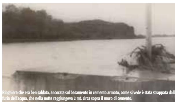
Ringhiera che era ben saldata, ancorata sul basamento in cemento armato, come si vede è stata strappata dalla furia dell'acqua, che nella notte raggiungeva 2 mt. circa sopra il muro di cemento.
